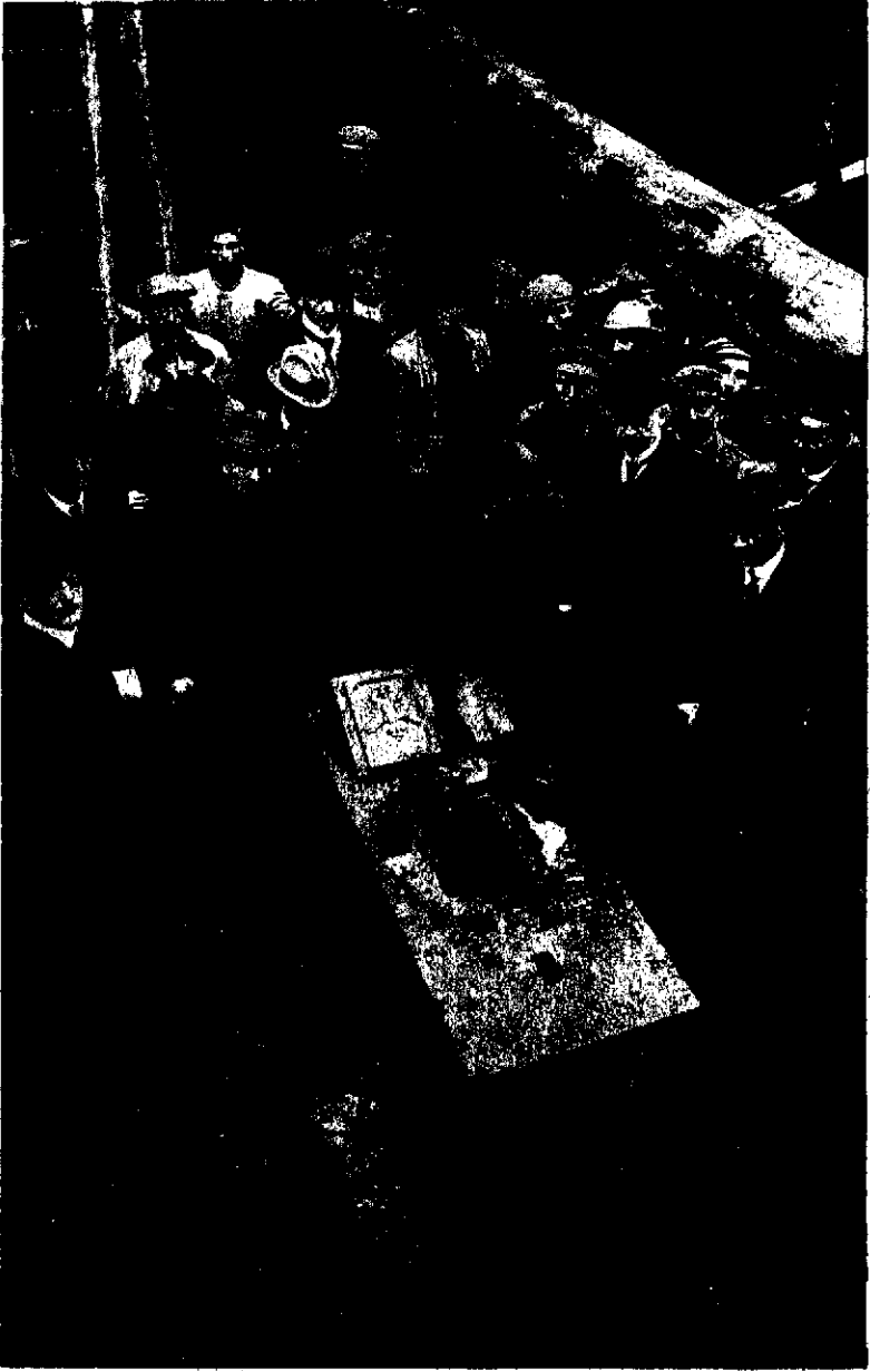
Öffnung des Grundsteines des nördlichen Kreuzbogenpfeilers der Alten Brücke am 21. November 1919.
