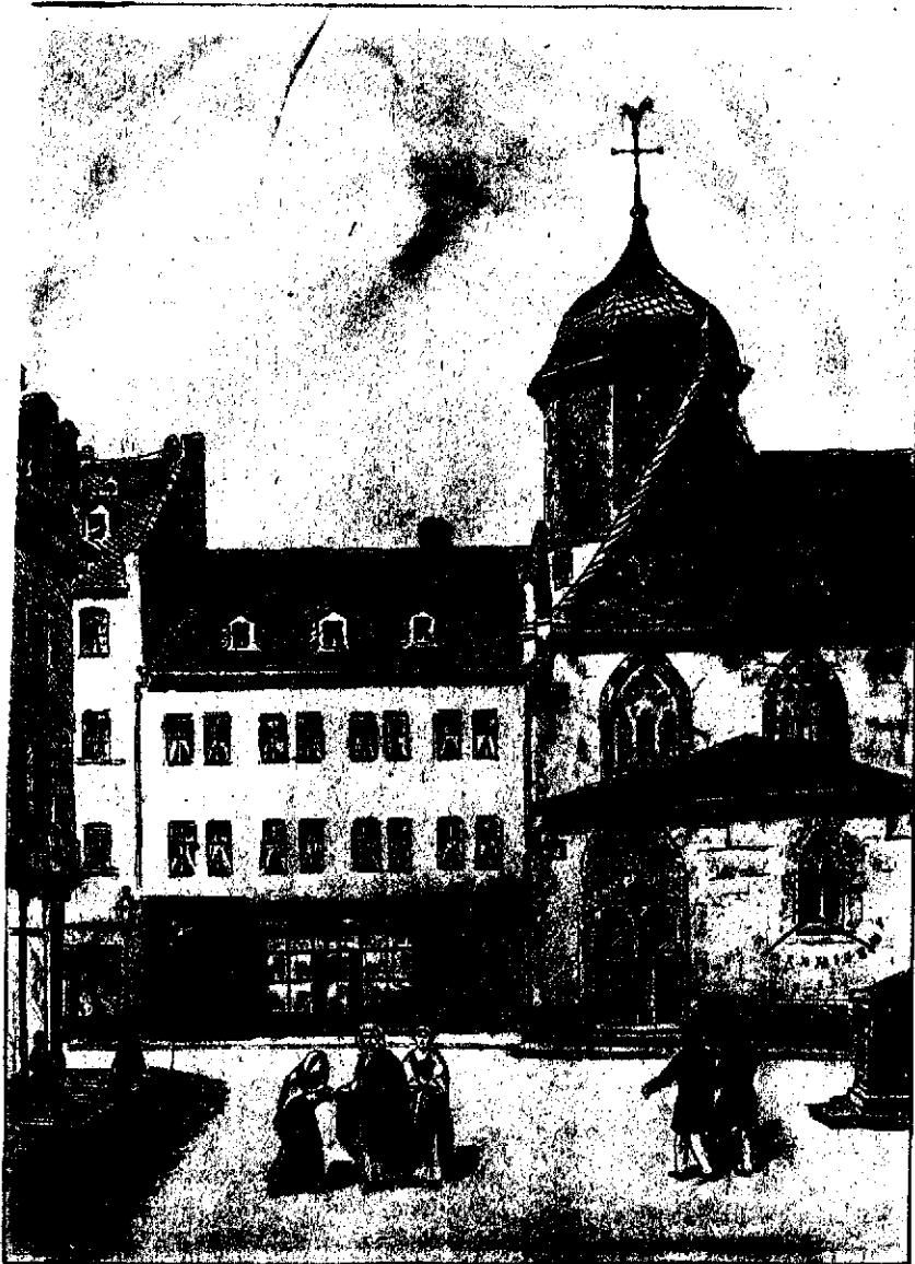
Durchbruch neben der Liebfrauentirche 1855.
