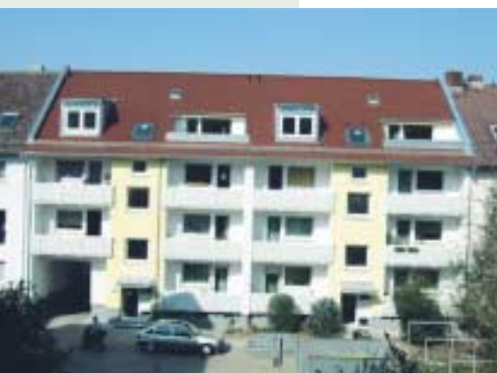
Dachgeschossausbau und Modernisierung in der Kochstraße 10 und 12
