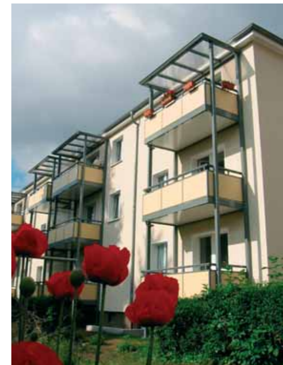
Balkonanlage Flensburger Straße
