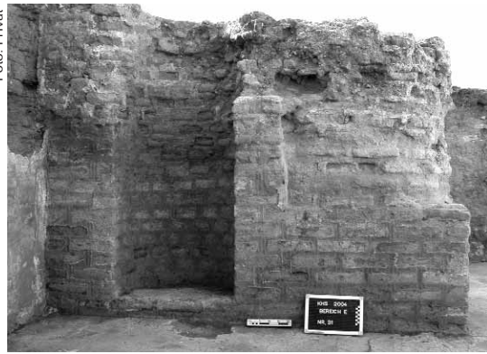
Massives Mauerwerk: Teilansicht aus dem Gebetsraum der Moschee mit seitlicher Gebetsnische
