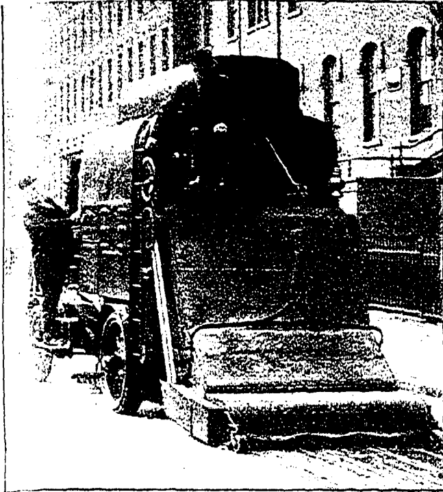
Eine neue Straßenreinigungsmaschine mit Automobilbetrieb.
