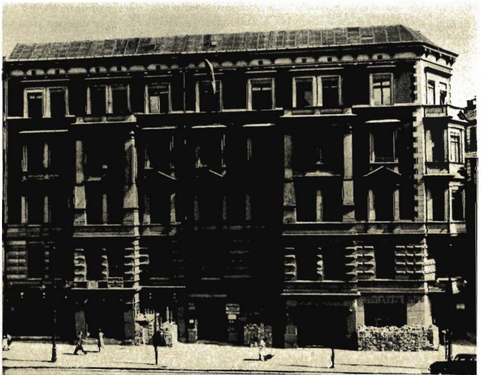
Kleiststr. 10—12 vor dem Umbau
