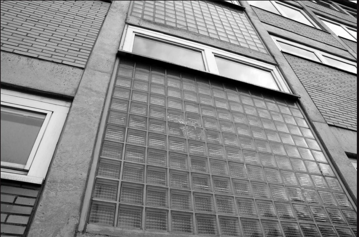
Typisches Element der Architektur Kramers ist ein nicht verblendetes Tragwerk aus Betonpfeilern, das mit hellen Klinkern ausgefacht ist - neben den Gebäuden entlang der Senckenberganlage ist diese Bauweise auch am ehem. Institut der Anglistik (Kettenhofweg) oder in den Instituten der Pharmazie (Georg-Voigt-Str.) zu beobachten. Vorteil dieser Bauweise ist, dass sie preiswert und platzsparend ist, gleichzeitig aber eine flexible Raumaufteilung im Inneren ermöglicht.
