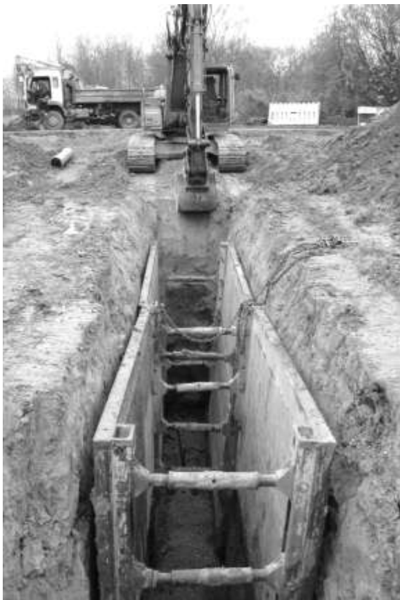
Abb. 20: Erneuerung der ca. 7 m tief im Boden liegenden Rohrleitungen in der Grube Rath (Bild: LANDSCHAFTSSTATION).
