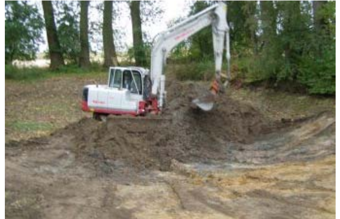
Abb. 1: Mit dem Bagger wird der trocken gefallene Teich vertieft.
