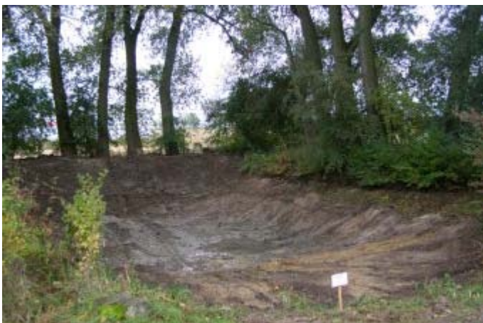
Abb. 3: Durch einen in Arbeiten an derartigen Gewässern erfahrenen Baggerführer geschaffene, annähernd
