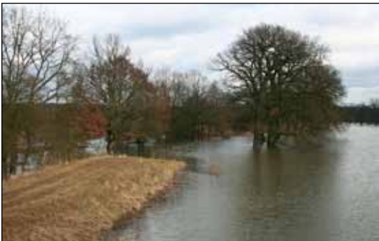
Abb. 3: Überschwemmte Deichöffnung an der „Versuchsstraße“ während des Hochwassers am 11. März 2009. Foto: G. Puhlmann.
