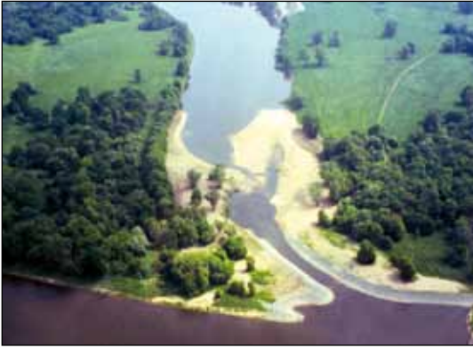
Abb. 4: Kurzer Wurf mit oberstromigem Einstrombereich (Elbe-km 250) nach dem Sommerhochwasser 2002. Foto: R. Apel (2003).
