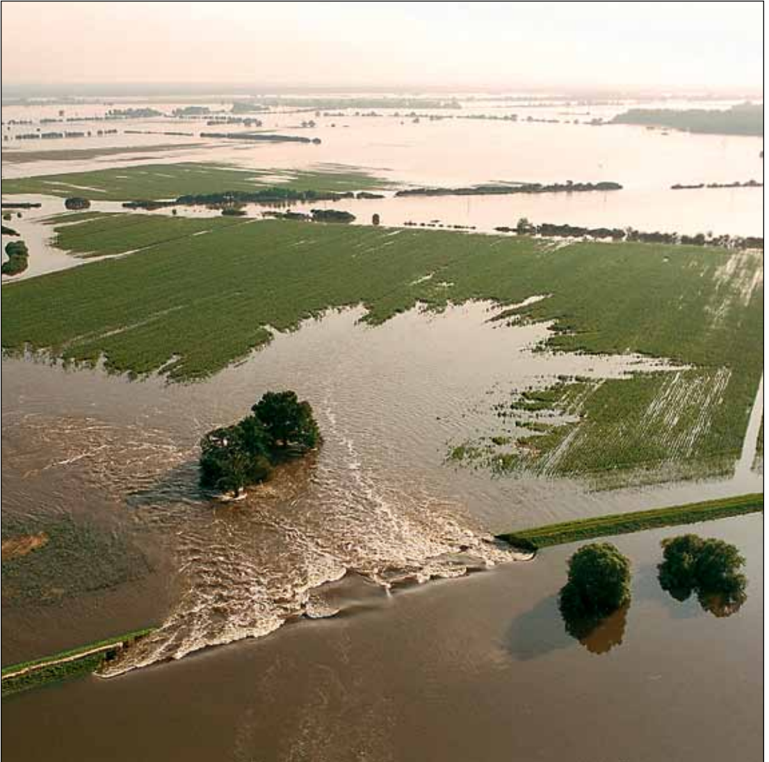
Elbehochwasser im August 2002, Landkreis Wittenberg. Foto: A. Künzelmann (UFZ).
