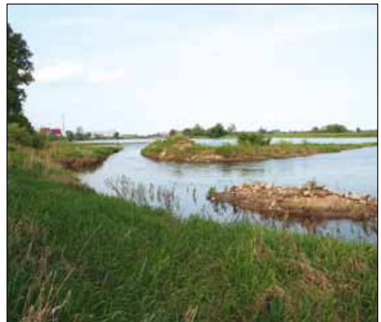
Abb. 5: Anlage einer Flutrinne hinter einer Bühnenwurzel bei Apollensdorf (Elbe-km 221,9 - rechte Elbeseite). Foto: A. Regner.
