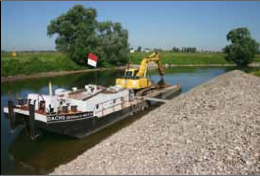
Abb. 15: Im Zuge der Gewässerunterhaltung mit Sohlmaterial verkippter ehemaliger Bienenfresserbrutplatz im Saalekreis. Foto: M. Schulze.
