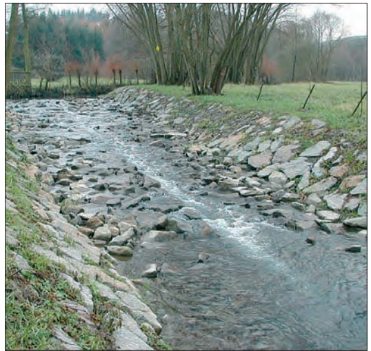
Abb. 2: Wehr Wippra / Wipper. Nach Rückbau und Errichtung einer rauen Sohlgleite mit Niedrigwasserrinne (Sicherung Fisch-Mindestwasserstand) ist die volle ökologische Durchgängigkeit gewährleistet (Aufnahme bei Niedrigwasserabfluss). Foto: C. BRÄUNIG.
