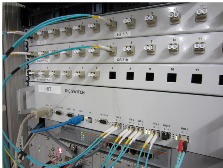
Abbildung 3.7.: Oben: Schema und Signalwege der Regelung mit *DIC*. Unten: Frontansicht des *DIC* sowie des darüber liegenden Patchfeldes, an dem die LWL-Verbindungen der Strahlziele ankommen. Der *DIC* ist die Arbitrier- und Regeleinheit, die aus den ankommenden Signalen sowohl das korrekte Strahlziel auswählt, als auch den Regler selbst enthält.
