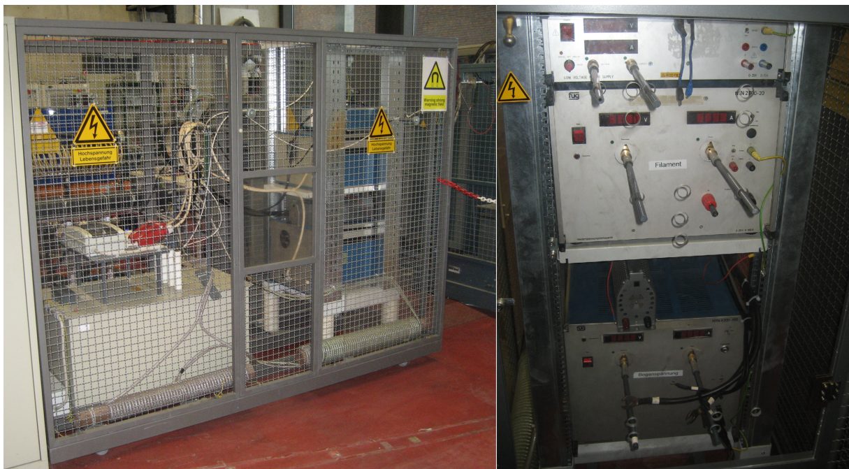
Abbildung 3.7: Links: Hochspannungsterminal von der Seite / Rechts: Blick auf die im Terminal verbauten Quellennetzteile
