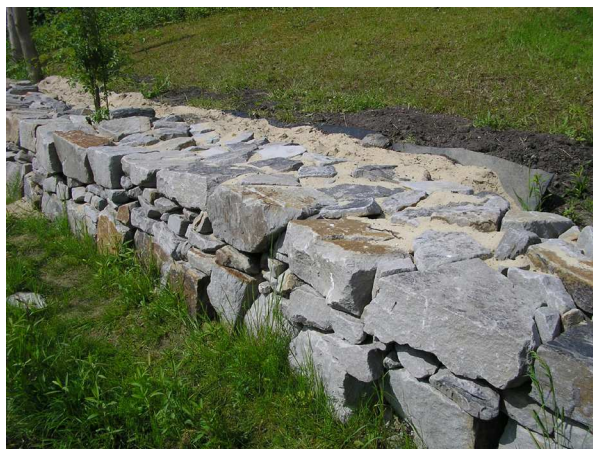
Abb. 12: Neu angelegte und daher noch vegetationsfreie, mit Sand verfugte Trockenmauer aus lokalem Naturstein (Ruhrkarbonischer Sandstein) im Lehrgarten der BUND-Kreisgruppe Herne (19.05.2012, P. GAUSMANN).
