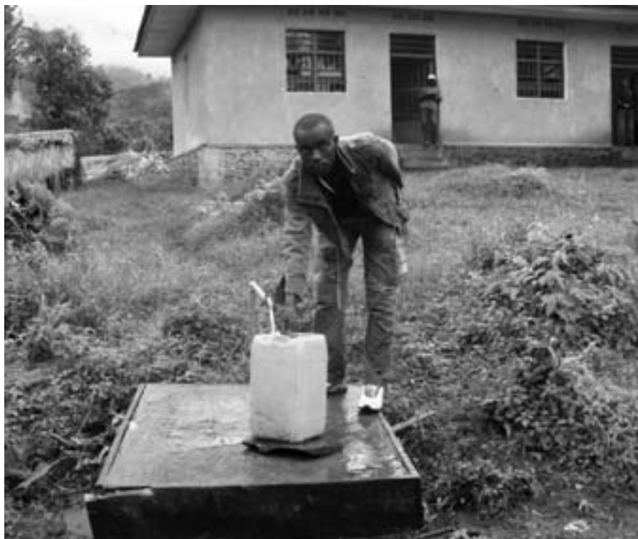
La conduite d'eau du poste de patrouille de Sarambwe est en fonction
