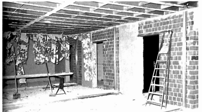
Ein Filmstudio wird Lager: Die alte „Kleine Aufnahmehalle“ hat eine Zwischendecke bekommen.
