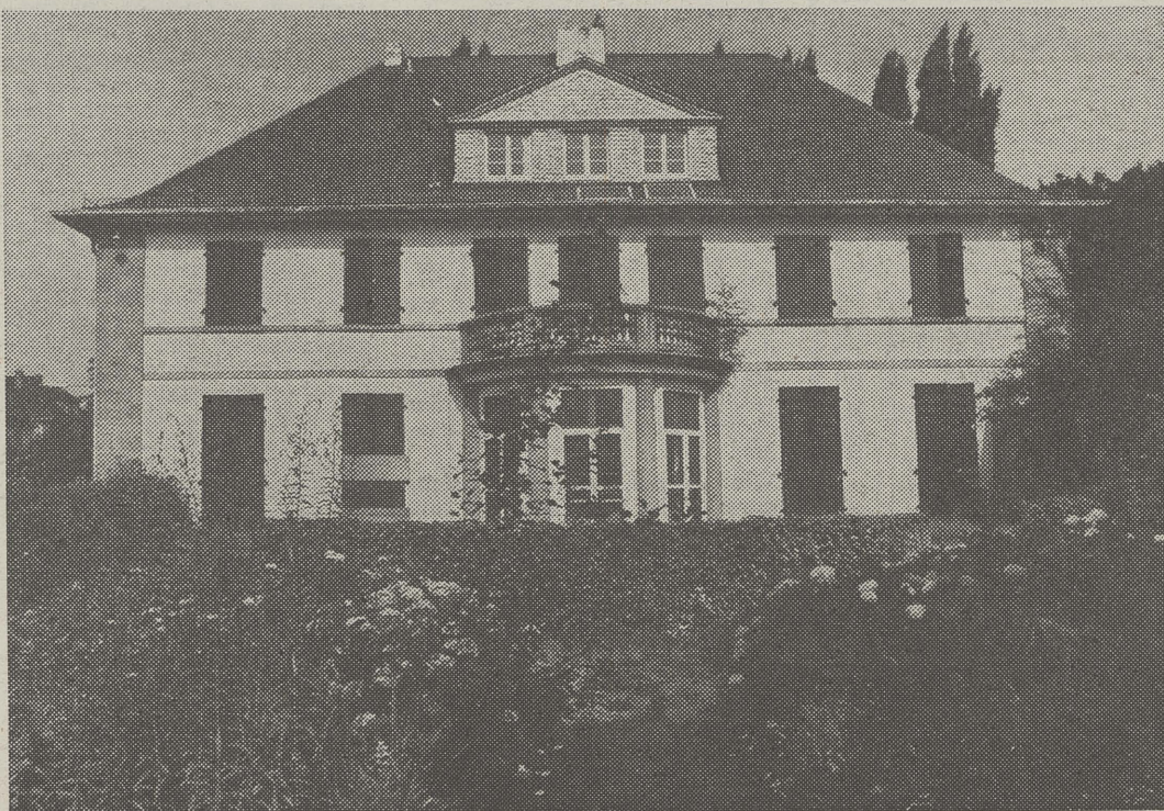
Die ehemalige „Generalsvilla“ wird zum Internationalen Begegnungszentrum um- und ausgebaut. Dabei entstehen auch zehn 1- bis 2-Zimmer-Appartements für Austauschstudenten und Wissenschaftler.
