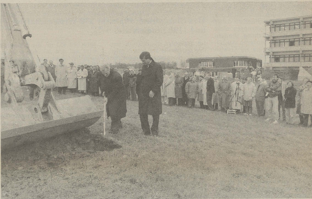
Wissenschaftsminister Dr. Wolfgang Gerhardt nahm den Bagger zum ersten Spatenstich für ein Biozentrum, Präsident Prof. Dr. Klaus Ring griff zum Spaten. 1993 soll der Komplex fertig sein. (Foto: Heisig)
