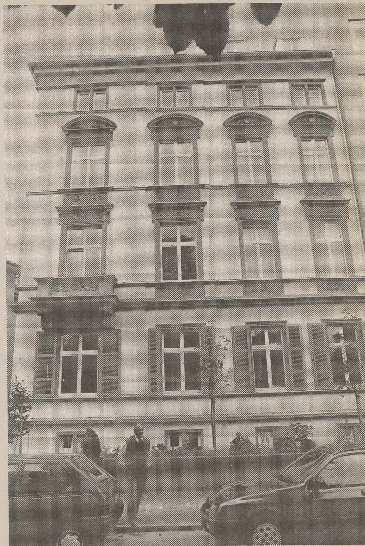
35 Wohnheimplätze für Studierende sind durch den Bauverein Katholische Studentenwohnheime am Westendplatz geschaffen worden. Das 1866 errichtete Gebäude, dem der Abriss drohte, wurde für 2,2 Millionen Mark renoviert und aufgestockt. 1,7 Millionen Mark gab die Landesregierung dazu, von der Stadt Frankfurt kamen 300 000 Mark. (Foto: Heisig)
