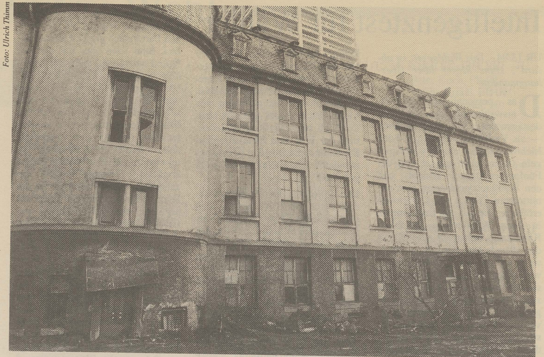
Verwittertes Zeugnis der Nachkriegszeit: die „Alte Chemie“ in der Robert-Mayer-Straße
