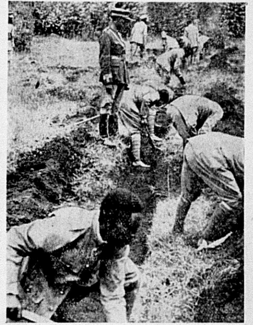
Beim Bau von Schützengräben. Abessinische Truppen beim Anlegen von Schützengräben.
