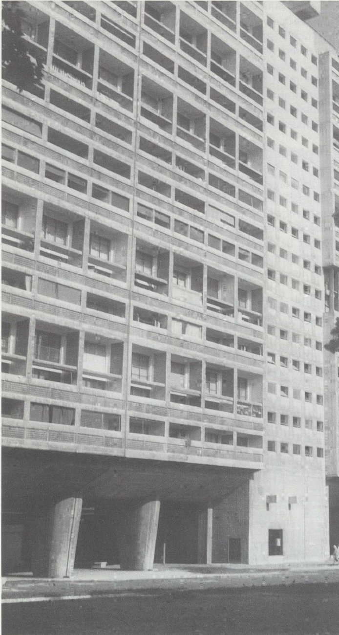
LeCorbusier, „Unité d'Habitation“. Ein maßgebliches Vorbild für den Wohnungsbau der Nachkriegszeit.
