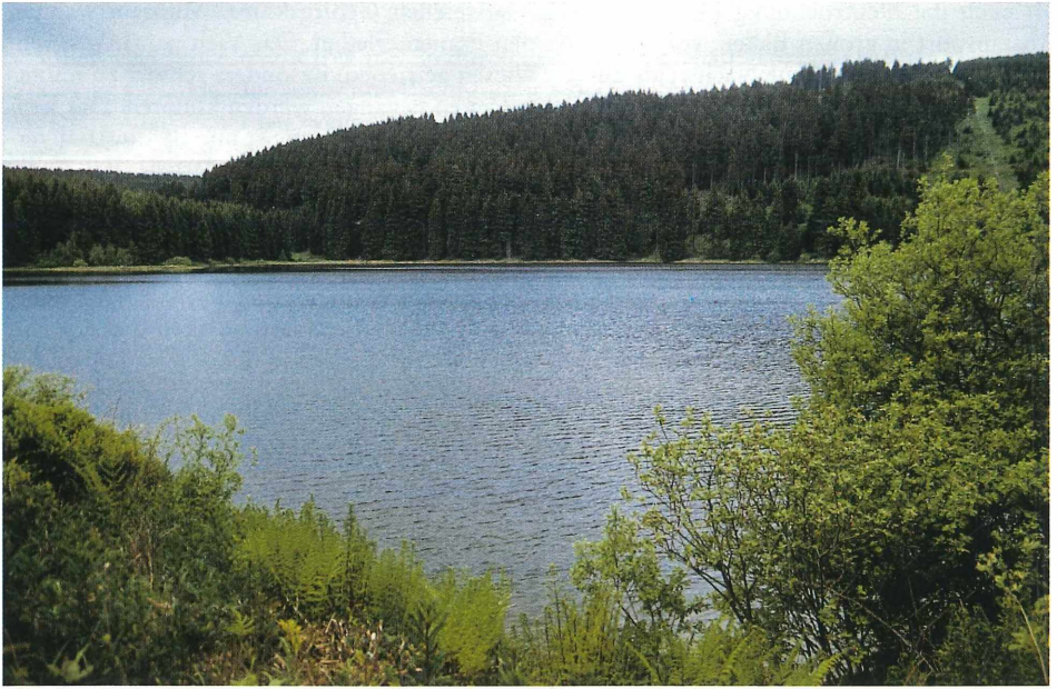
Bild 25: Der Große Kellerhalsteich bei Clausthal-Zellerfeld (erbaut 1724) ist der drittgrößte Stauteich des Oberharzer Wasserregals (580 m NN).
