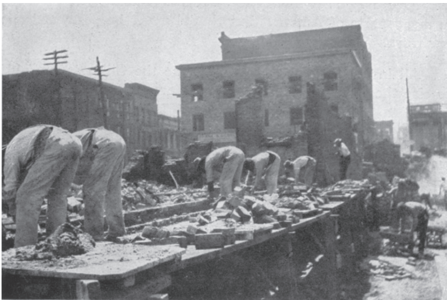
Abb. 8 b: Gilbreth: Baustellenfoto
