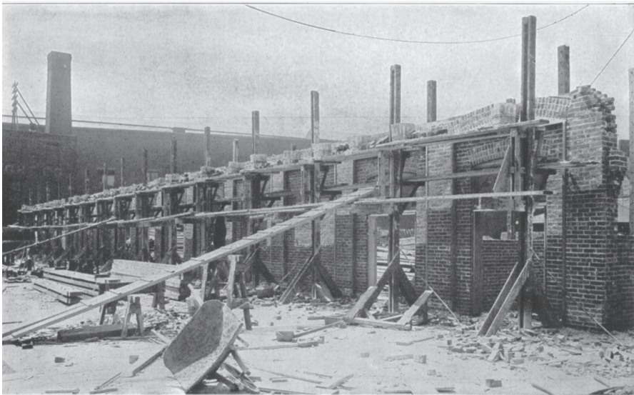
Abb. 8 a: Gilbreth: Baustellenfoto
