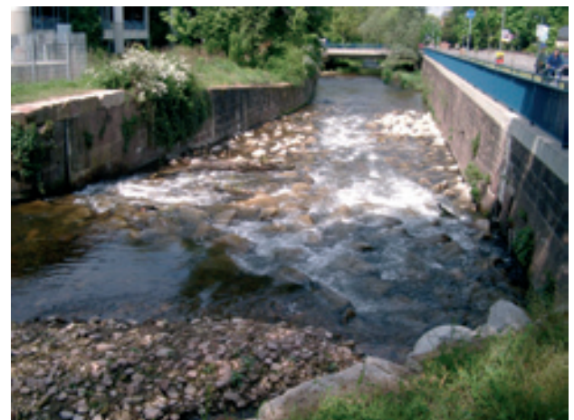
Wehranlage vor und nach dem Umbau Raue Rampe in der Alb
