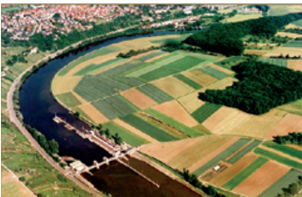
Luftbild Staustufe „Poppenweiler“ und Gelände Zugwiesen
