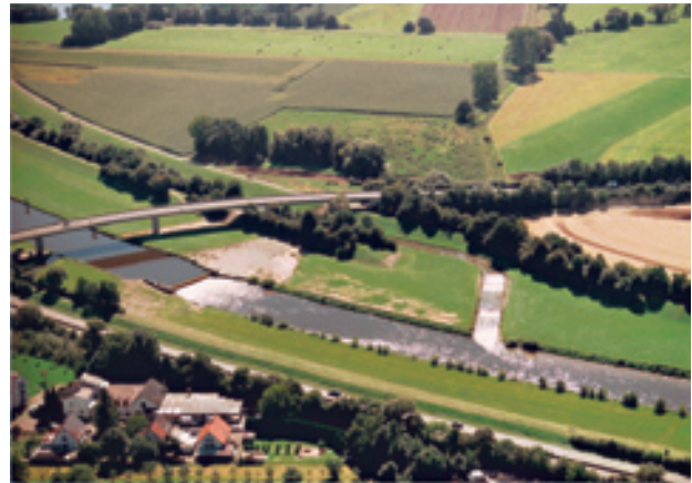
Bild 1: Mündung der Schutter vor dem Umbau
