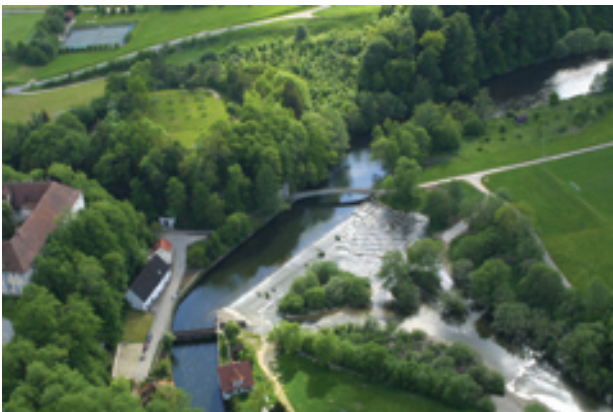
Streichwehr in Obermarchtal mit integrierter Fischrampe
