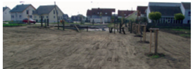
Bild 6: Multifunktional nutzbare Flächen um Versickerungsmulden während der Bauphase...
