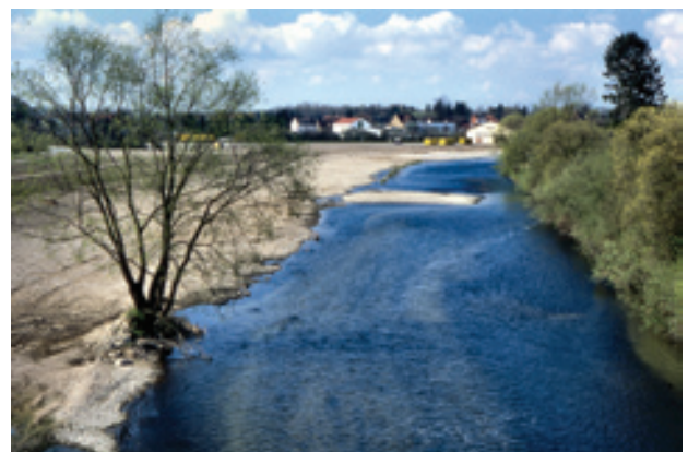
1997: dto. unmittelbar nach der Baustellenphase, Uferückverlegung links
