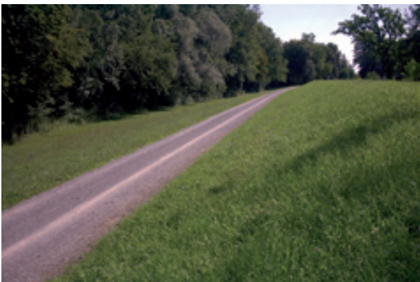
Rheinhochwasserdamm bei Leopoldshafen
