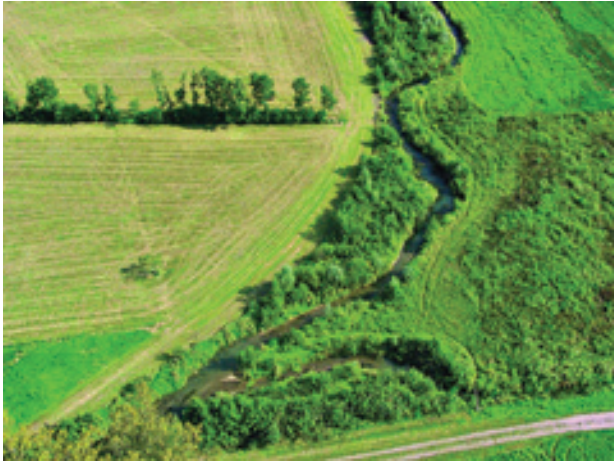
Umgestaltung der Kammbachmündung bei Willstätt
