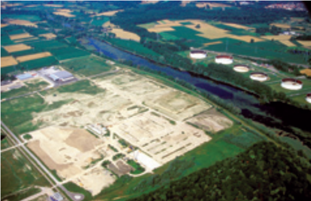
Rückbau einer Industrieanlage und Rückführung in den Auenbereich bei Karlsruhe
