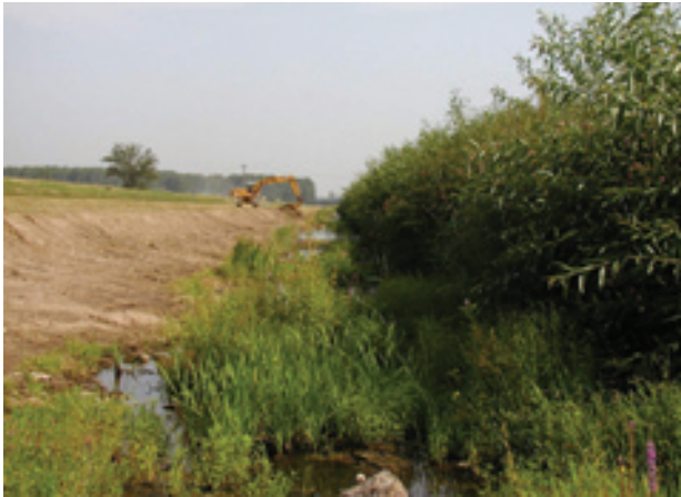
Wechselseitige Räumung am Renchflutkanal
