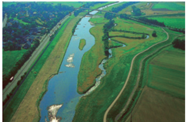
Bild 2: Mündung der Schutter nach dem Umbau
