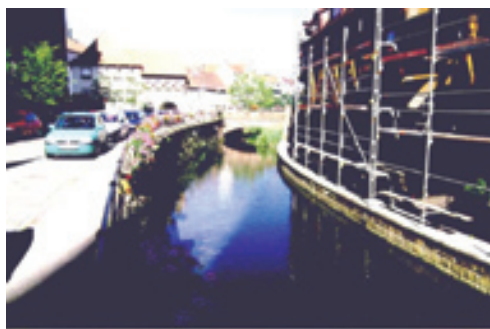
Bach in der Ortslage mit kastenförmigem künstlichem Gewässerbett
