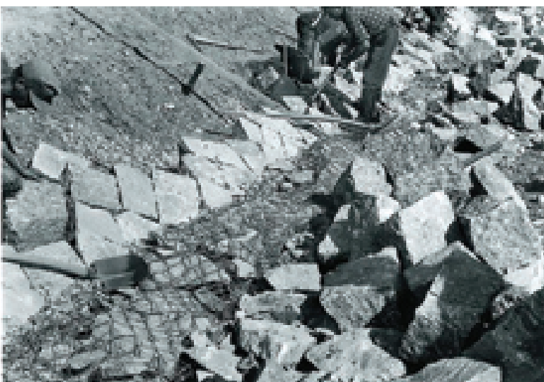
Pflasterarbeiten beim Bau des Renchflutkanals im Jahr 1953
