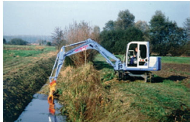
Wechselseitiger Mähkorbeinsatz an einem Entwässerungsgraben
