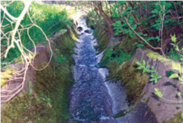
Sohlschalen unterhalb der Ittersbacher Straße
