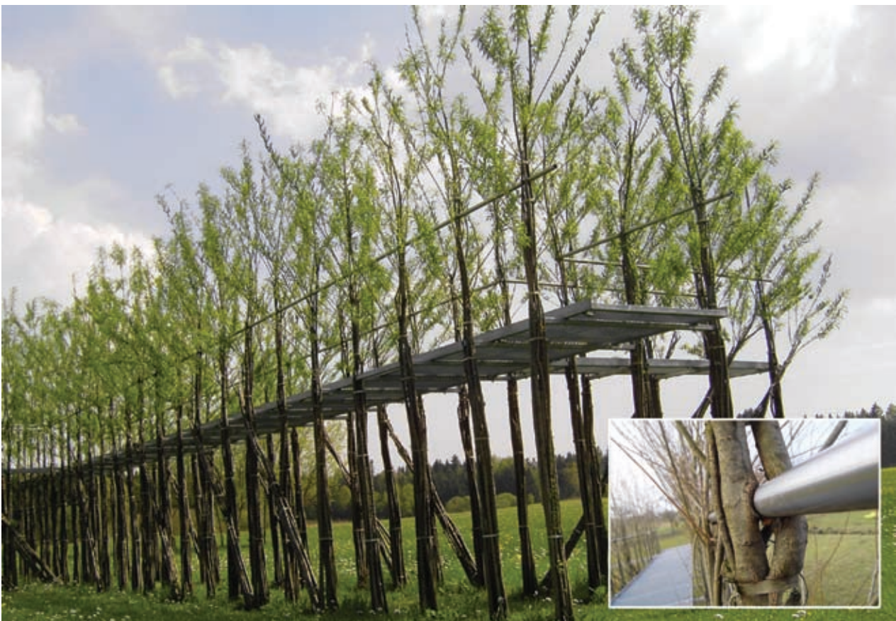
Skywalk am Ried: Pilotprojekt aus lebenden, zu 64 Stützen gebündelten Weiden, Metallrohren und Stahlgitterrosten.
