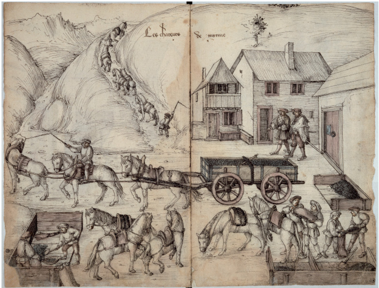
Abb. 4. Historische Darstellung (16. Jh.) des Transportes von zerkleinertem Erz mittels tierischer Zugkraft und vierrädrigen Wagen bei der Silbermine Saint-Nicolas de la Croix, Frankreich (bpk/RMN – Grand Palais/image Beaux-arts de Paris).
