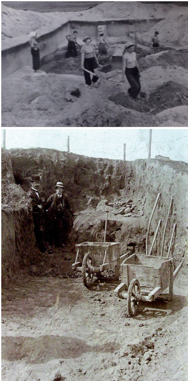
Abb. 15. Für den Transport von Schüttgut in großen Mengen, jedoch ohne die Nutzung von größeren Wagen und tierischer Zugkraft, sind in der Vorgeschichte diverse Transportmittel aus Holz denkbar. Beispiele von historischen Ausgrabungen: a (oben) – typische Bautrage für zwei Personen auf einer Ausgrabung 1957 in Russland (Foto: A. Parunin, Shadrinsk), b (unten) – hölzerne Schubkarren bei der Ausgrabung des Grabhügels „Heidenberg“ in Schortewitz, Lkr. Anhalt-Bitterfeld, im Jahr 1913 (Foto: Prähistorische Sammlung Köthen, mit freundlicher Genehmigung A. Geisler).
