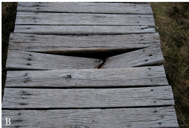
Abb. 3. Rezenter Moorweg im Naturpark Schwarzes Moor, Ldkr. Rhön-Grabfeld mit verwitterungsbedingten Schäden und Reparaturstellen (Fotos S. Burmeister/L. Schupp).
