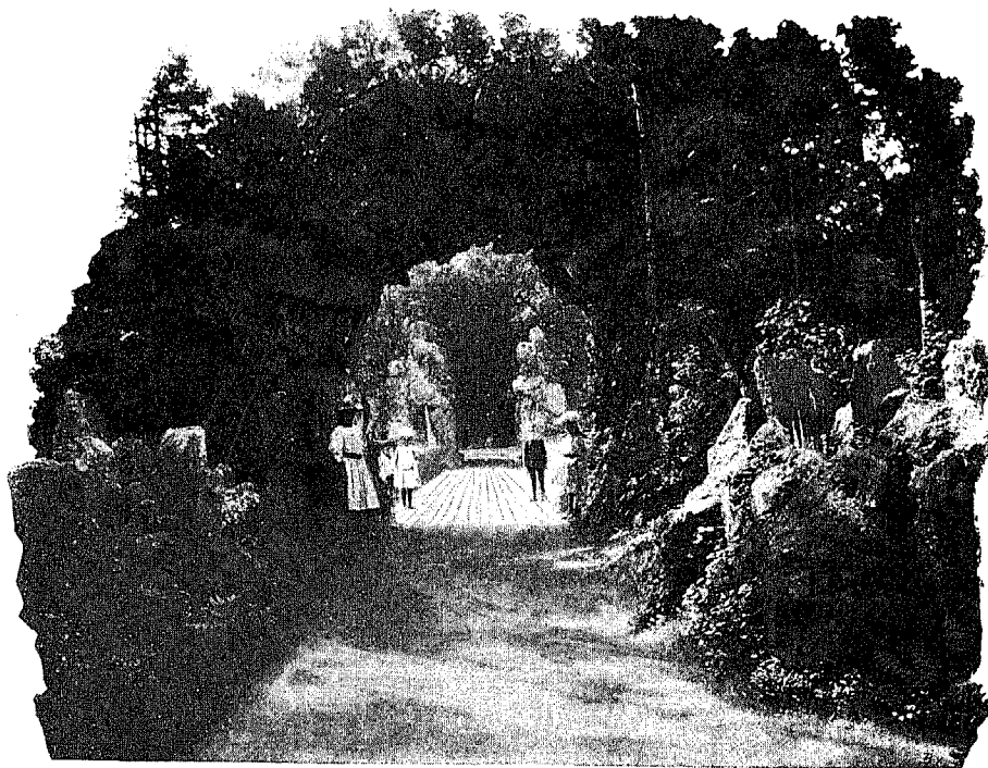
Fig. 10. Blick über die Brücke.
