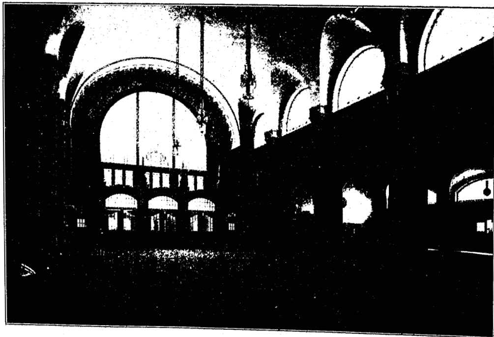
Abb. 12. Schalterhalle, nach Norden gesehen.
