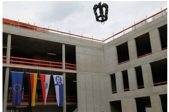
Am 29. Mai wurde das Richtfest des zweiten Bauabschnitts gefeiert.
