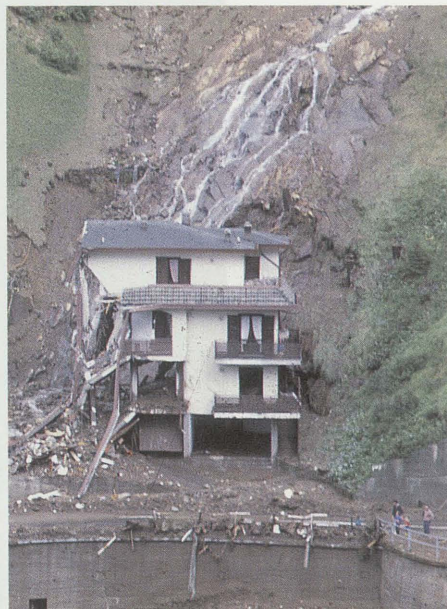
Abb.3: Durch die Geröllmassen, die sich bei dem Erdbeben im Veltlin in den oberitalienische Zentralalpen lösten, wurden am 28. Juli 1987 zahlreiche Häuser zerstört.
