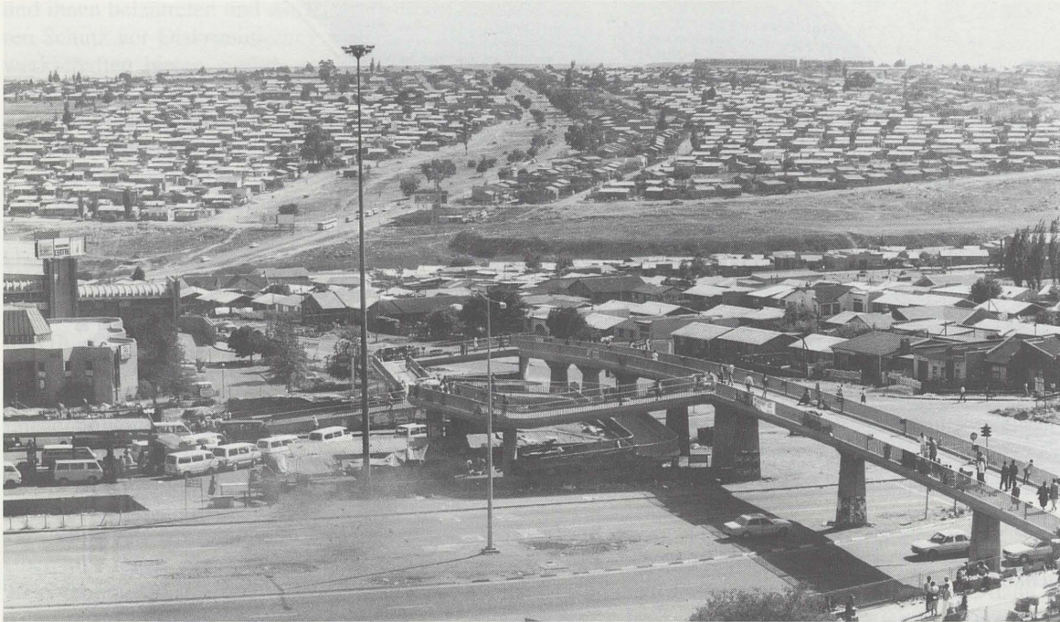
South Western Township – kurz „Soweto“: Offiziell leben in diesen von der weißen Regierung am Rande von Johannesburg errichteten Townships etwa 3,5 Millionen Schwarze, vermutlich sind es doppelt so viele. Die meisten der mit Asbest gedeckten Steinhäuser sind im Besitz des Staates.
