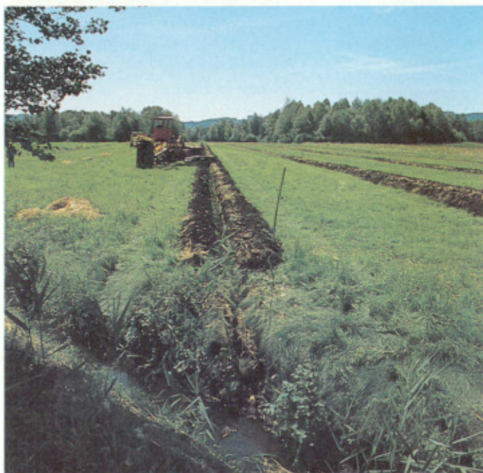
Anlage von Rohrdrainagen in Naßwiesen
