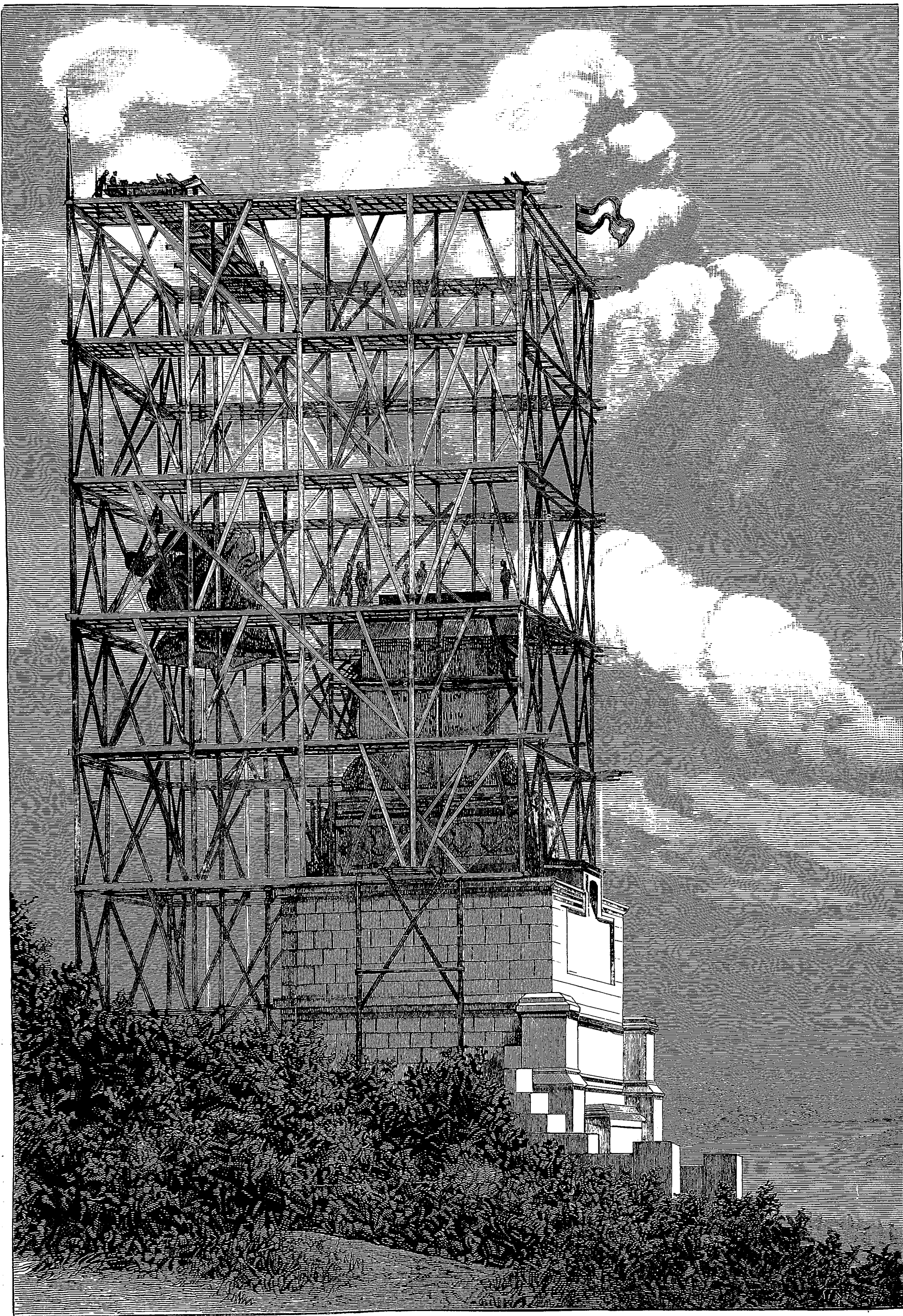
Die Aufstellung der Germania-Statue auf dem Niederwald: Der Aufzug des untersten Gussstücks der Germania auf das Postament. Originalzeichnung von Ferdinand Lindner.
