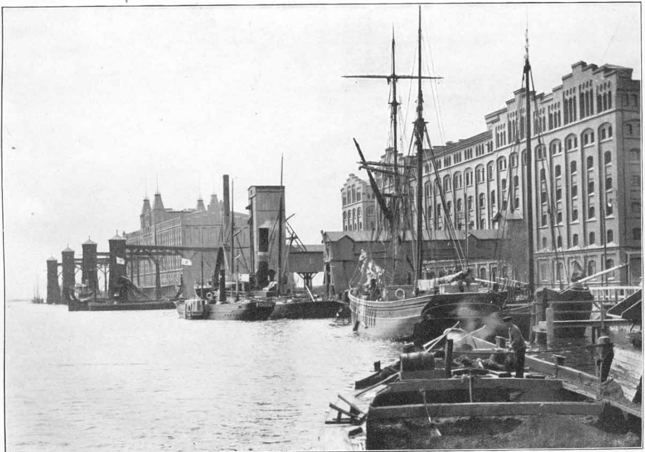
Getreide-Lagerhaus (Silospeicher). — Walzmühle.
