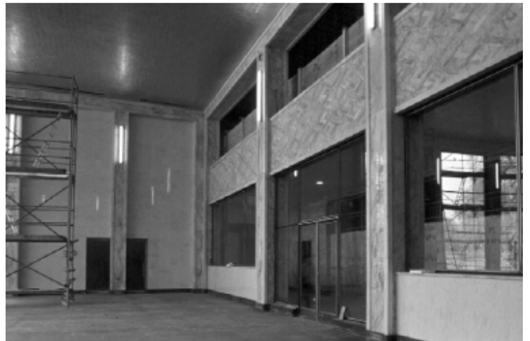
... doch die künftige Cafeteria nimmt zusehends Gestalt an. Eisenhower-Rotunde, Montag, 30. April
