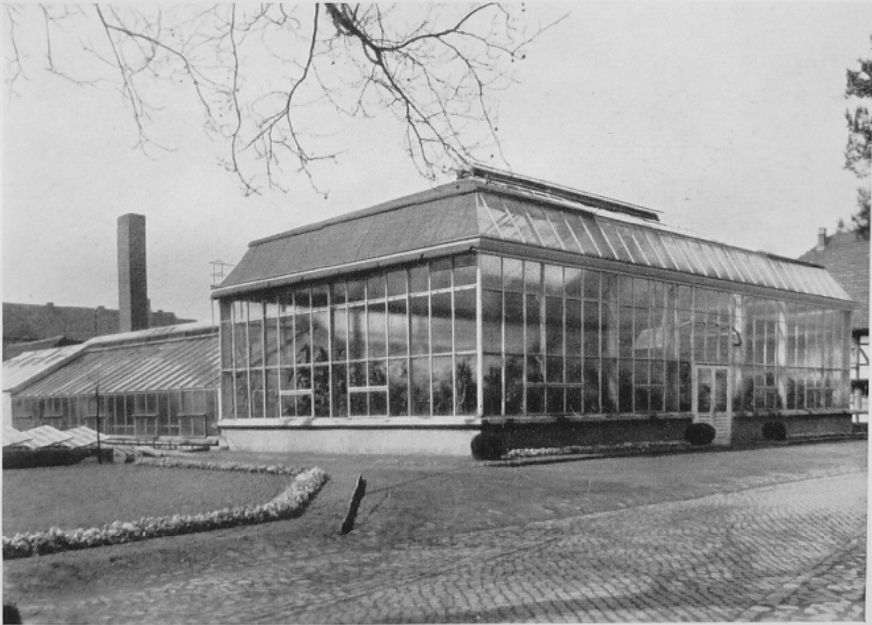
neue Gewächshaus (Teilanlicht)
