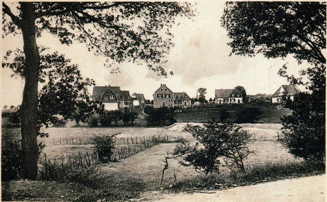
LENNEP. Beamtenhäuser am Ostring
