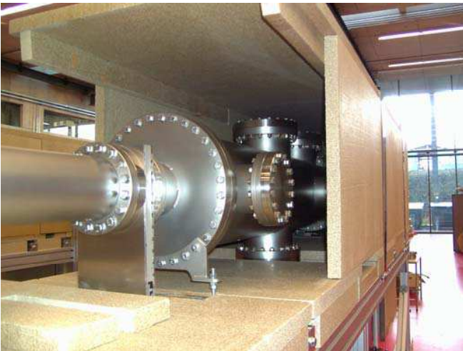
Abbildung 2: Detailansicht des Speicherrings bei der Einhausung in den Heizzunnel aus Vermiculite®-Platten.
