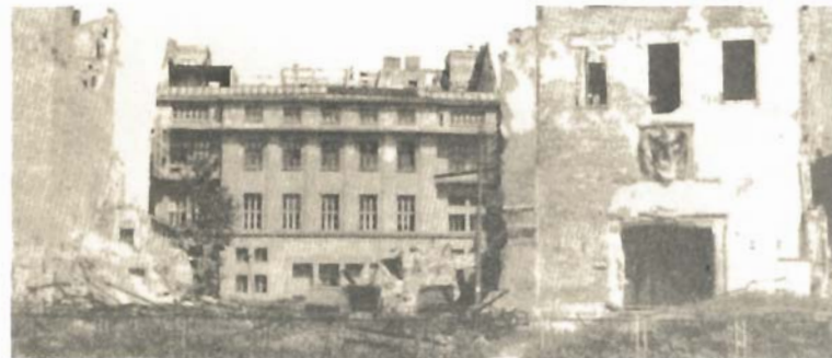
Abb. 16: Die zerstörte Reichsanstalt (1945)
