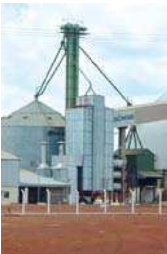
Verarbeitungsanlage der Firma Bunge
