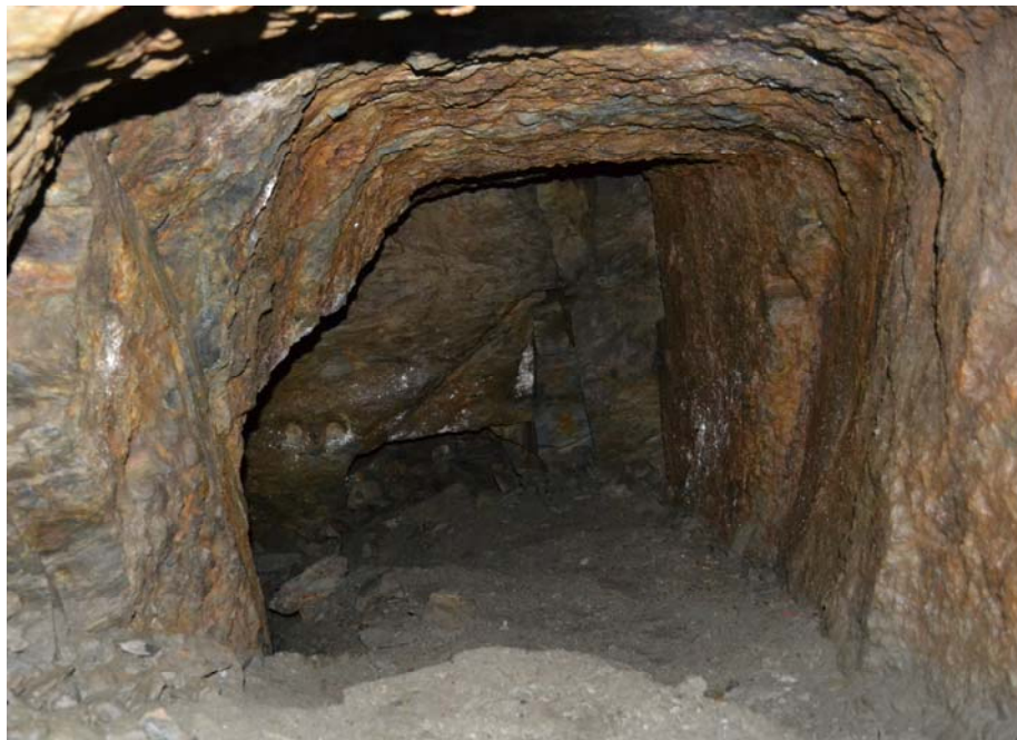
Abb. 10 Três Minas. Galeria dos Alargamentos. Treppenschacht. Situation zwischen oberem und unterem Spalt. Blick von C nach D (s. Abb. 8. 9). Firste und westlicher Stoß sind vollständig, östlicher Stoß ist teilweise abgebrochen. Bei Position D ist die abgesenkte Fortsetzung des Treppenschachts als Profil in der Felswand und östlich daran anschließend sind die beiden runden Einarbeitungen erkennbar. (Foto Helfert)
