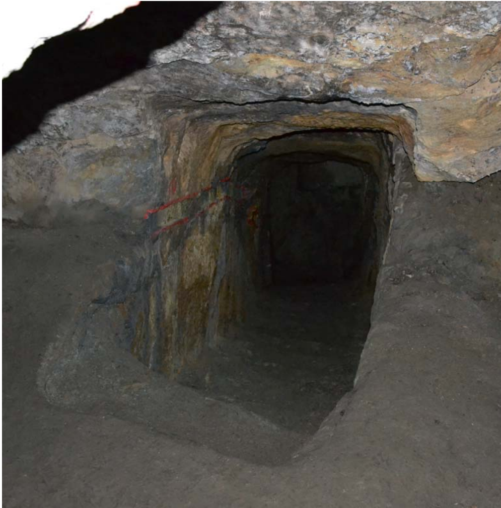
Abb. 7 Três Minas. Galeria dos Alargamentos. Treppenschacht im südlichen Stoß. Er weist eine leichte Krümmung nach Osten auf. Die ersten Treppenstufen durchstossen die Sohle der Galerie. Im Hintergrund sind der abgesenkte Felsblock und der verkeilte Felsblock sichtbar (= Position B in Abb. 8. 9). Von Norden. (Foto Helfert)
