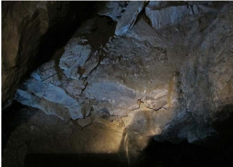
Abb. 11 Três Minas. Galeria dos Alargamentos. Treppenschacht. Position B-C (s. Abb. 8. 9). Rest der Mauer, die zur Sicherung vor seitlichen Schutteinbrüchen im oberen Spalt gebaut wurde. Von Südwesten. (Foto Wahl-Clerici)
