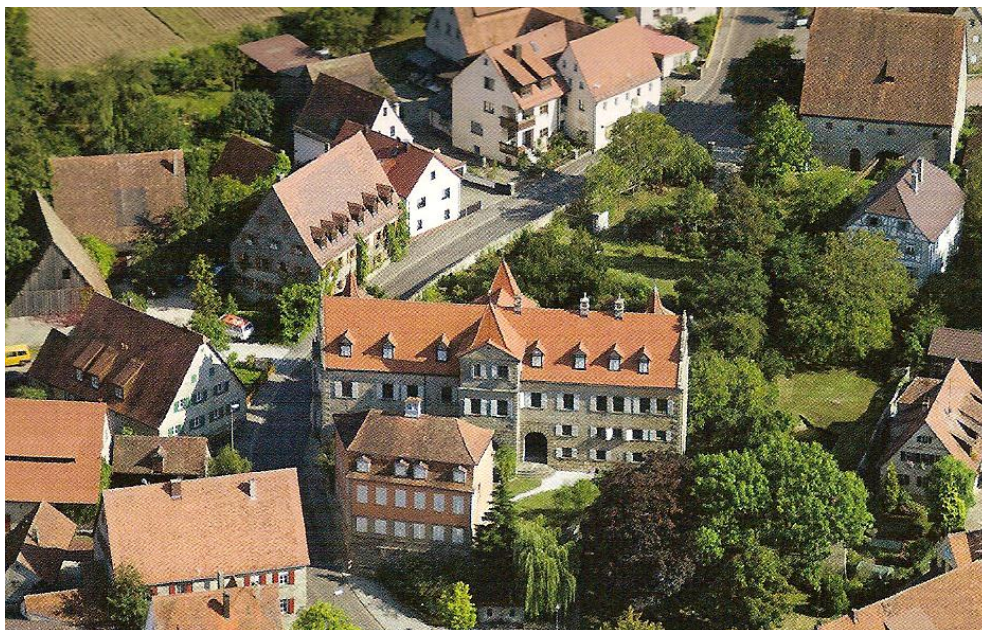
Abb. 13.3 Welserschloss Neunhof, Luftaufnahme
