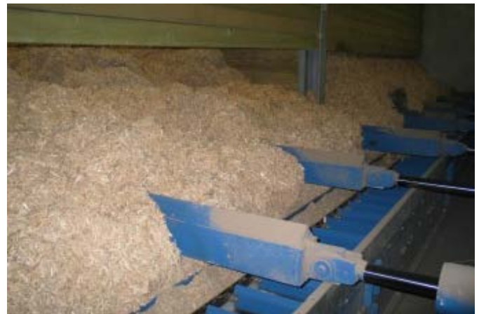
Abb. 2: Energetische Nutzung des Waldrand-Holzes: Hackschnitzel-Feeder eines größeren Holz hackschnitzel-Heizwerks in Brakel, Kreis Höxter (Foto: Walter KÖBLE).
