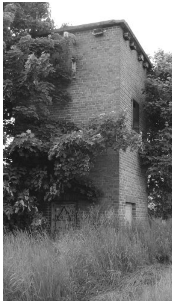
Abb. 4: Aufgelassener Trafoturm an der Alten Ziegelei
