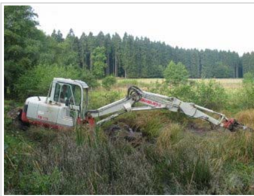
Abb. 18: Entschlammung eines Gewässers im NSG „Pölinxer Grund“ durch Baggereinsatz (Foto: Uli Wycisk)
