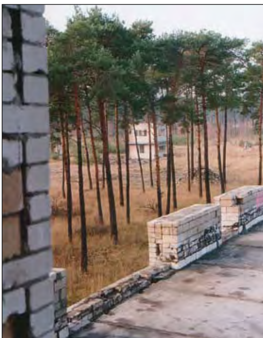
Abb. 30: Reste der Kommandostände an der ehemaligen Feuerlinie (abgerissen). Foto: B. Simon (10/1995).
