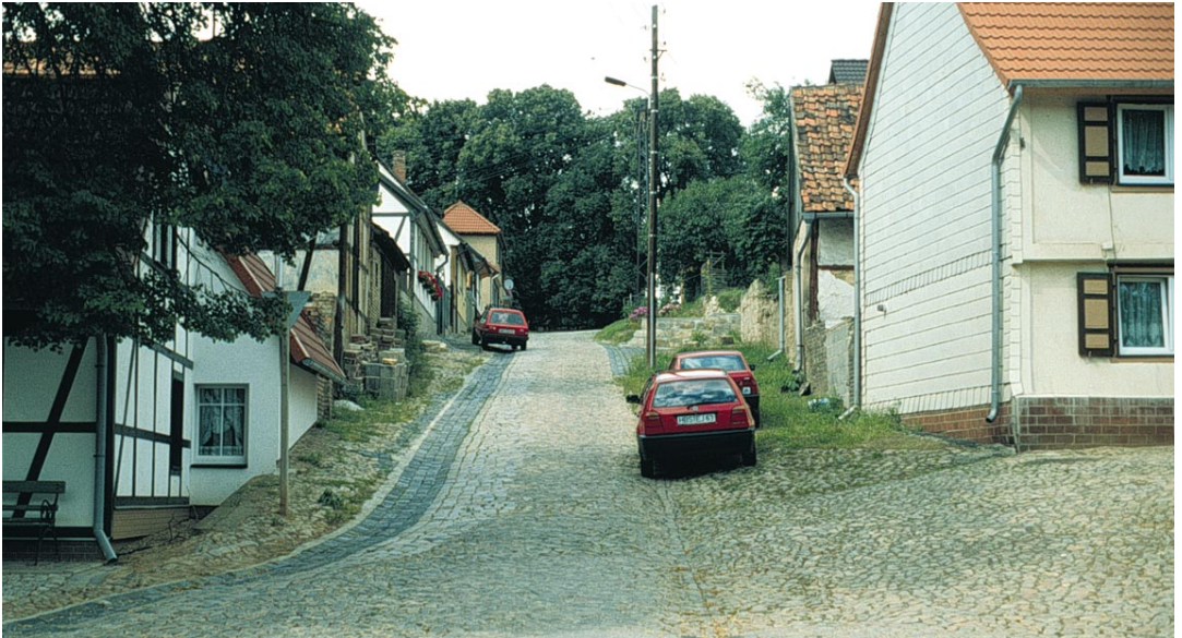
Abb. 2: Friedhofstraße nach dem Neubau im Rahmen der Dorfentwicklungsplanung, das historische Pflaster wurde teilweise wiederverwandet, rechts neue Bäume mit Raseneinsaat (2001) (Foto: A. Käzel)
