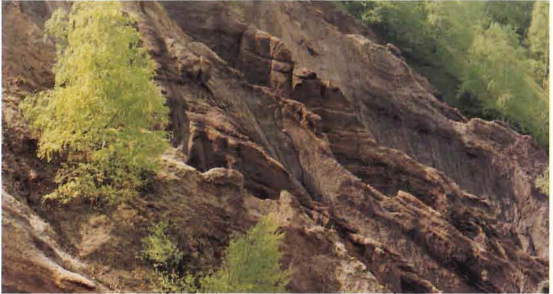
Abb. 7: Permanenter Hangwasseraustritt, stark schüttend, eisenreich (Foto: K. Heyde, 1993)
