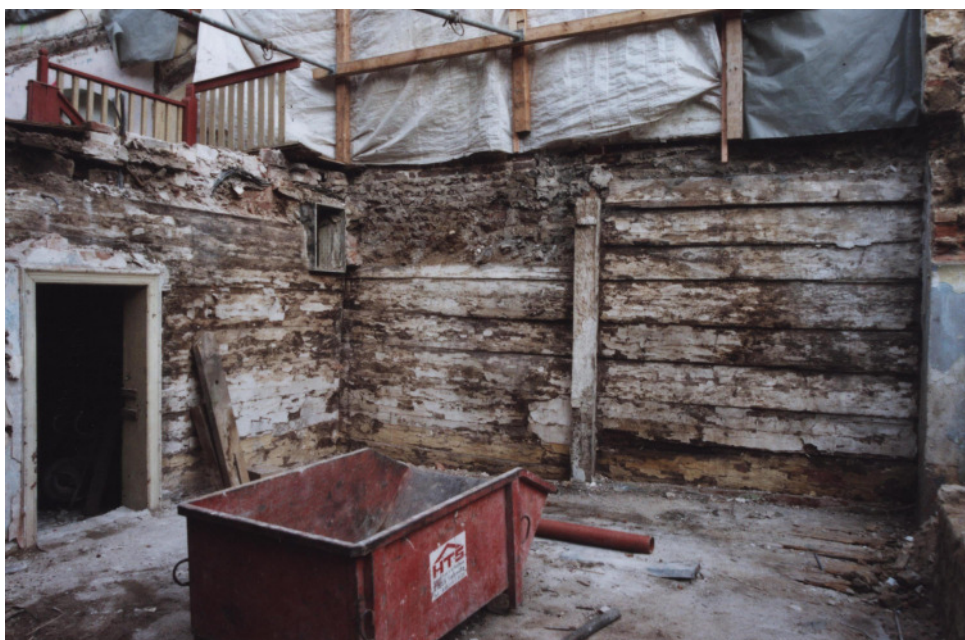
Abb. 1: Blick auf die Seitenwände der Pirnaer Blockstube vor der Demontage. Die stark komprimierten und mit Lehm verklumpten „Lagerfugen-Moose“ wurden aus den Fugen zwischen den Balken geborgen (Foto: A. Sturm).
