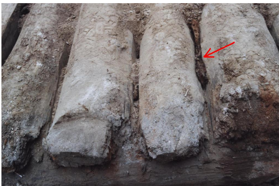
Abb. 3: Ausschnitt der Decke der Blockstube mit zwischen den Balken als Dichtungsmaterial eingefügten Moosen (roter Pfeil) (Foto: A. Sturm).
