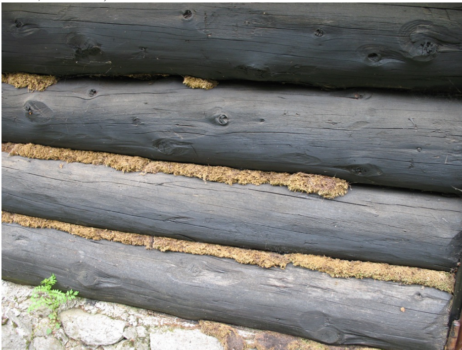
Abb. 7: Detail der Seitenwände der Blockhütte von Abb. 6 mit großen Mengen von als Dichtungsmaterial verwendetem Moos, hauptsächlich Hypnum cupressiforme (Foto: F. Müller, 30.05.2007).
