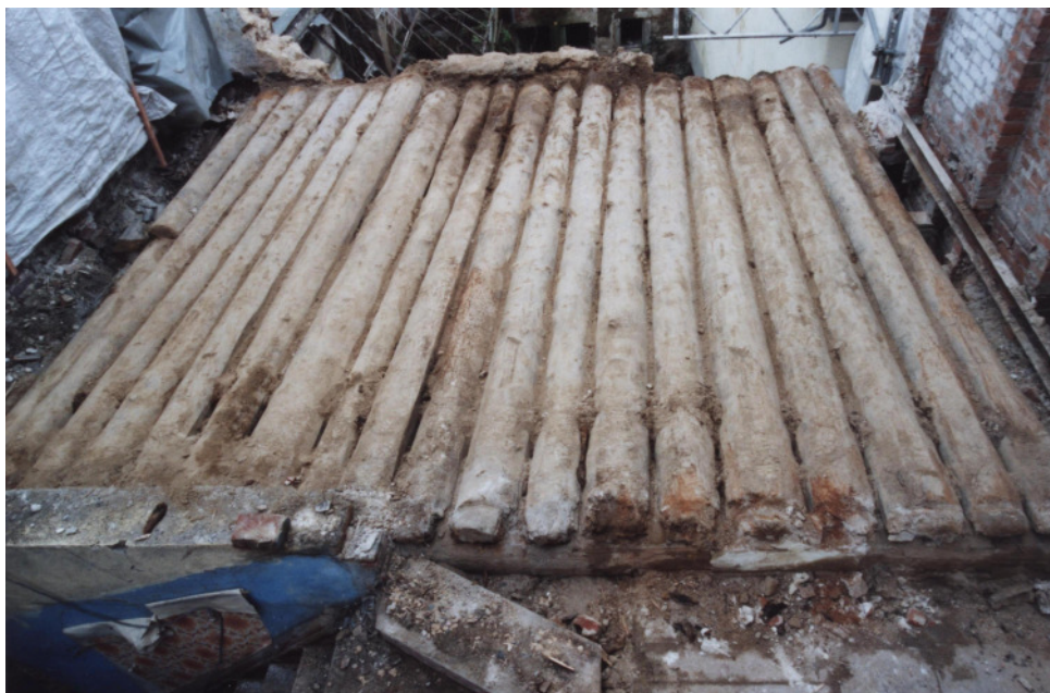
Abb. 2: Blick auf die aus Halbhölzern der Tanne aufgebaute Decke der Blockstube vor der Demontage. Moose fanden sich in größerer Menge in den keilförmigen Zwischenräumen zwischen den Balken (Foto: A. Sturm).
